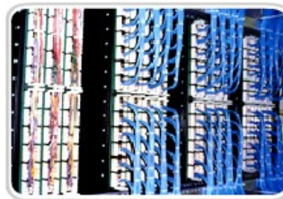
Panneaux de brassage à paires torsadées non blindées dans une baie
